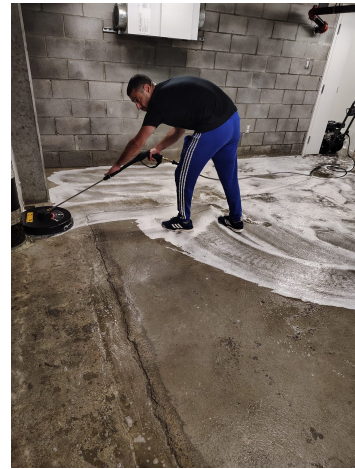
Action mécanique uniforme sur les zones de béton exposées.
