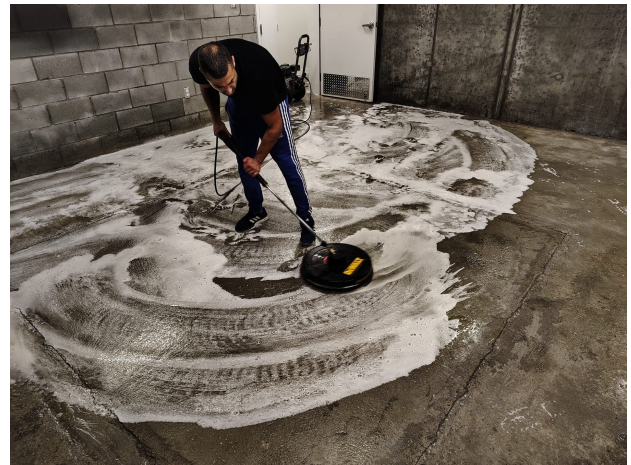
Passage mécanisé sur les zones larges afin de décoller les dépôts incrustés.
