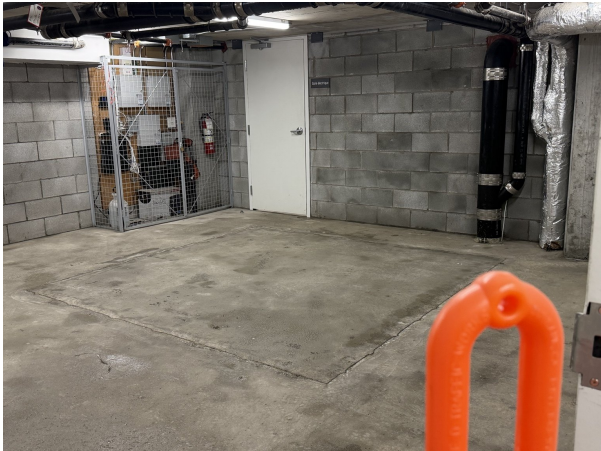
Vue générale après intervention: plancher rincé, surfaces dégagées, salle remise propre et odeurs éliminées.
