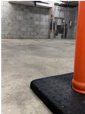
Contrôle au sol: surface rincée et assainie après passage mécanique.
