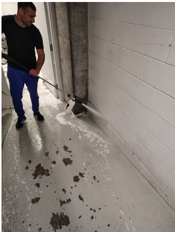
Application de mousse nettoyante sur les zones de circulation et les surfaces contaminées.
