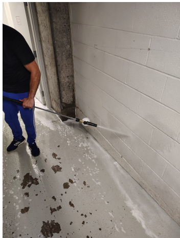
Rinçage dirigé sur les bas de murs et les zones de rétention.
