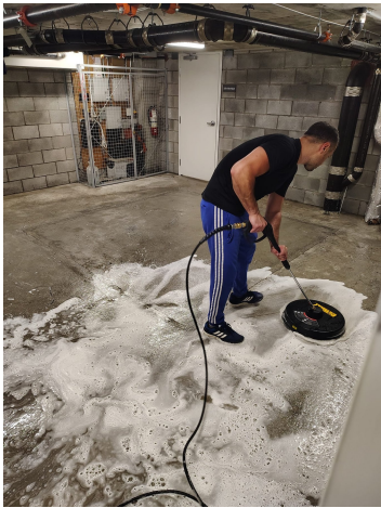
Nettoyage mécanisé du plancher avec nettoyeur de surface DEWALT.
