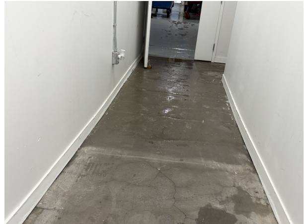
Corridor technique rincé, désinfecté, traité anti-odeurs et évacué après les travaux.
