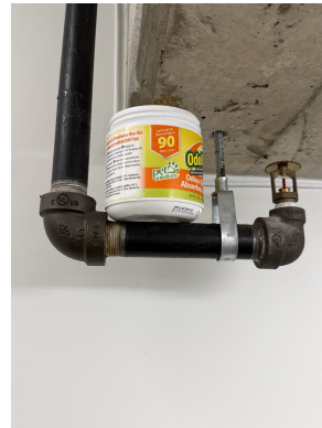
Placement discret en hauteur afin de soutenir le maintien d'une qualité d'air stable.
