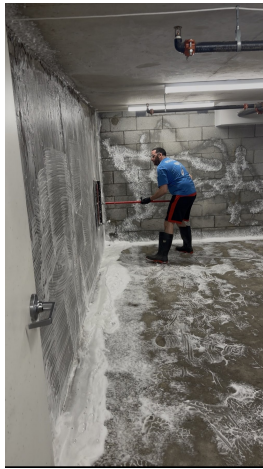
Brossage manuel des murs et des joints de blocs de béton.
